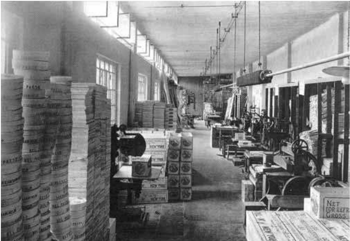
Reparto imballaggi dello stabilimento di Melzo (1934)
